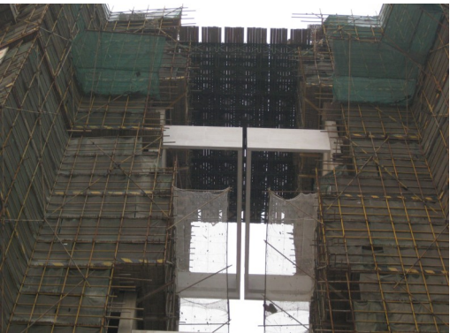
拆模后现浇构件
